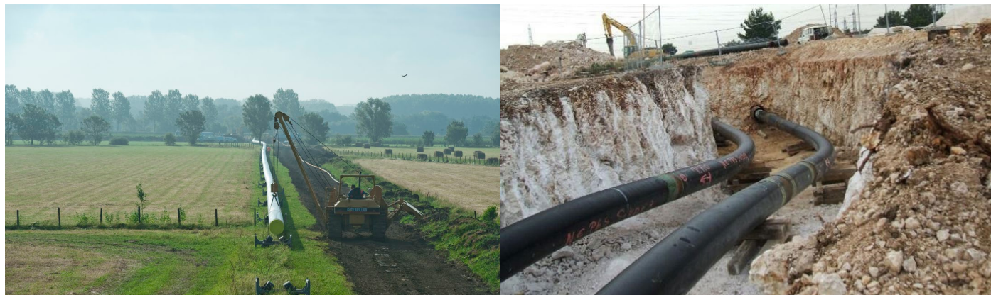
Exemples de canalisations NaTran, avant enfouissement
