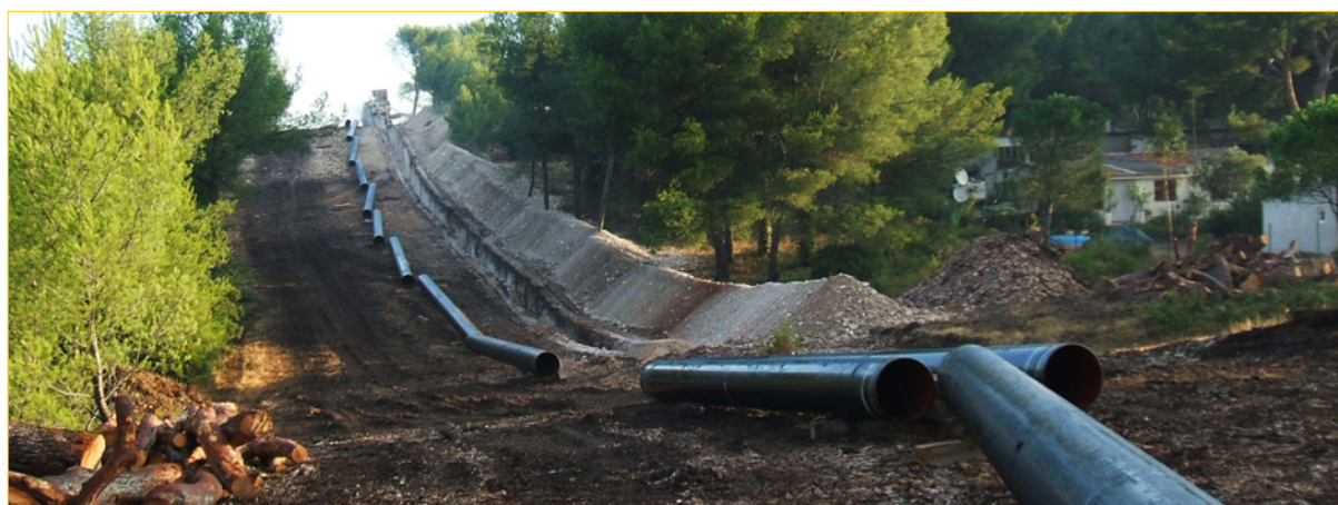
Exemples de canalisations NaTran, avant enfouissement
