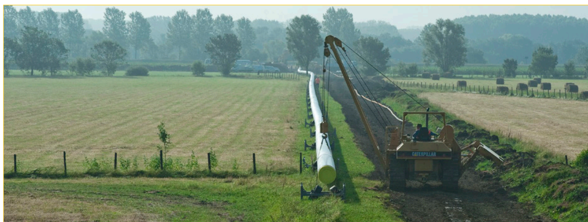
Exemples de canalisations NaTran, avant enfouissement
